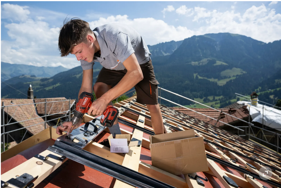
Schnupperlehrling Loris Steiner schraubt eine Vorrichtung für Solarpanel an.
